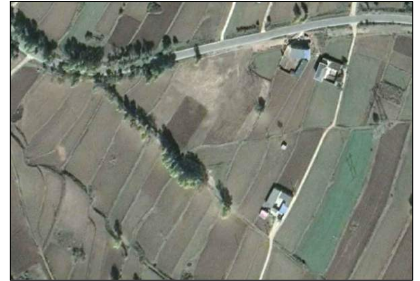
混凝土拌合站
