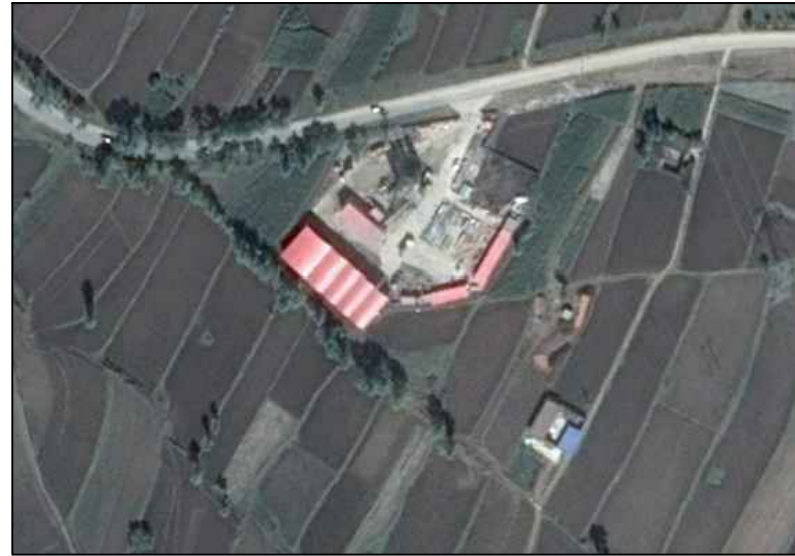
混凝土拌合站
